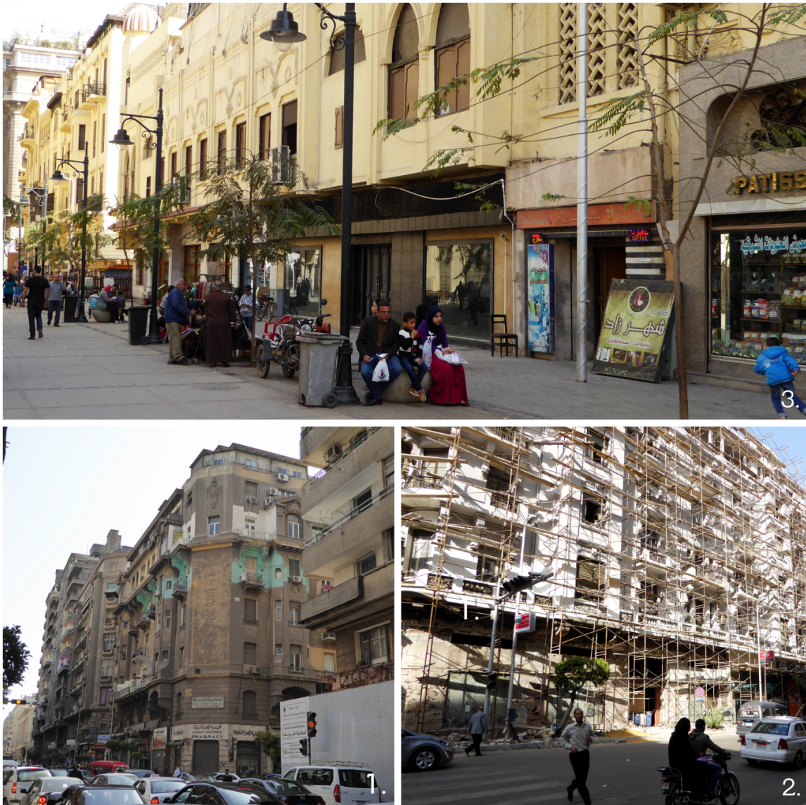
Fig. 14 Ravalement de façades à Downtown 199
